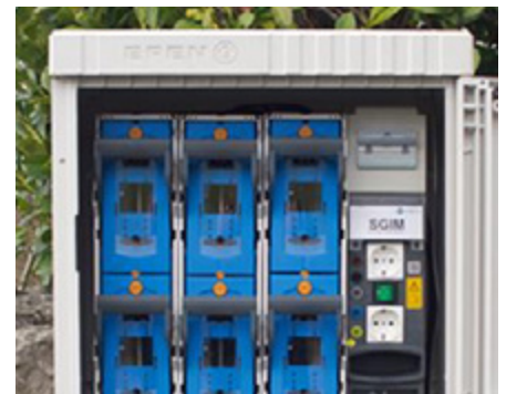
Das kompakte SGIM lässt sich einfach auf dem Reserveplatz im KVS nachrüsten.
