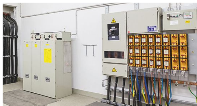
Sicherheits-Schnittstellen von EFEN für MS / NS Safety-interfaces from EFEN for MV-/LV-distribution
