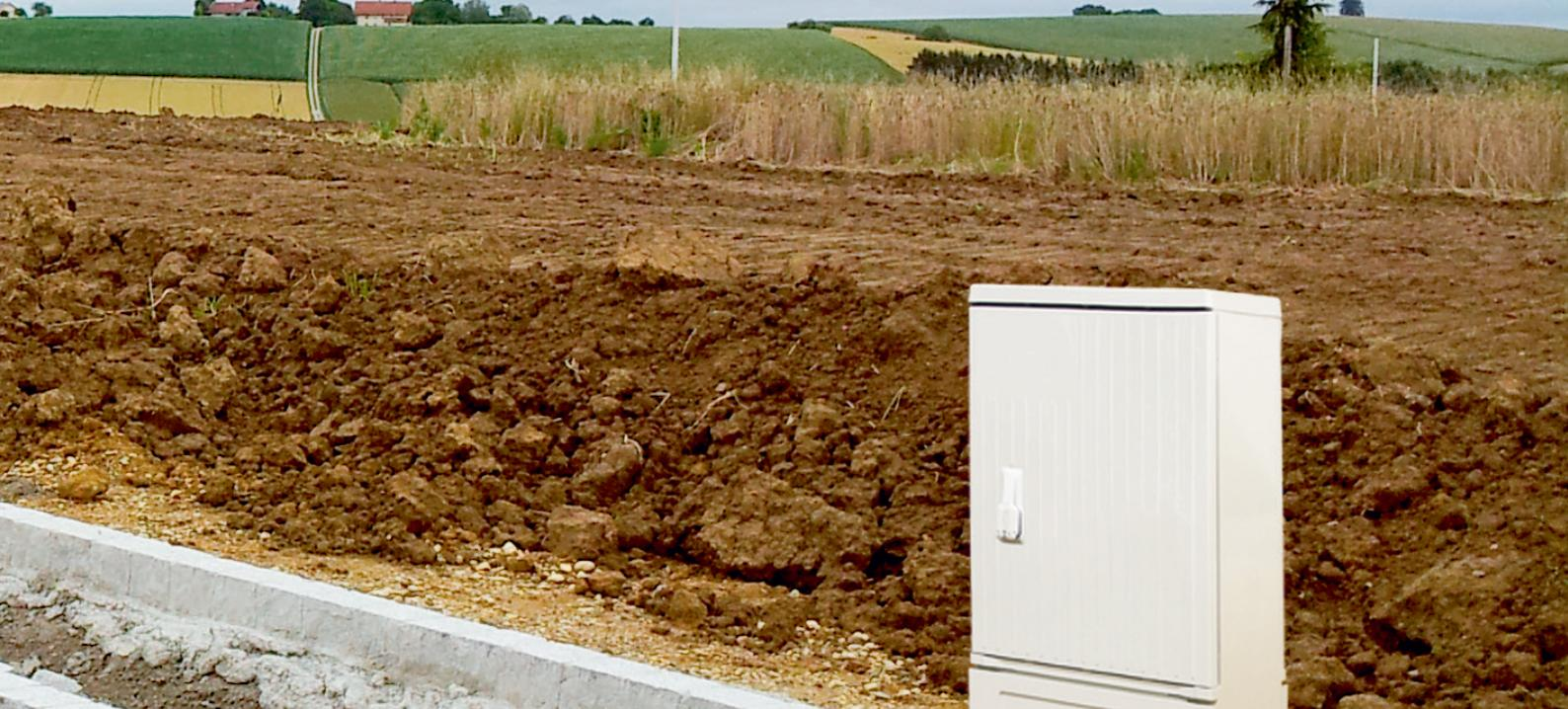
Die Abmessungen der Säulen sind in Übereinstimmung mit der DIN 43629 Teil 1, Teil 2 und Teil 3. Die Säulen sind in den DIN-Größen 00, 0, 1, 2 erhältlich.
