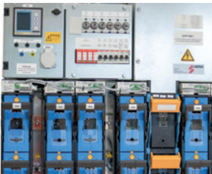
Die kompakte Messtechnik von EFEN lässt sich einfach in Ortsnetzstationen nachrüsten.
